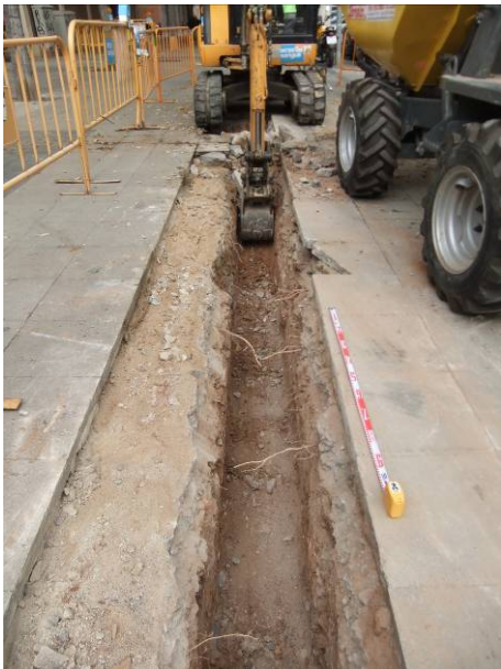
9. Obertura de la rasa.
