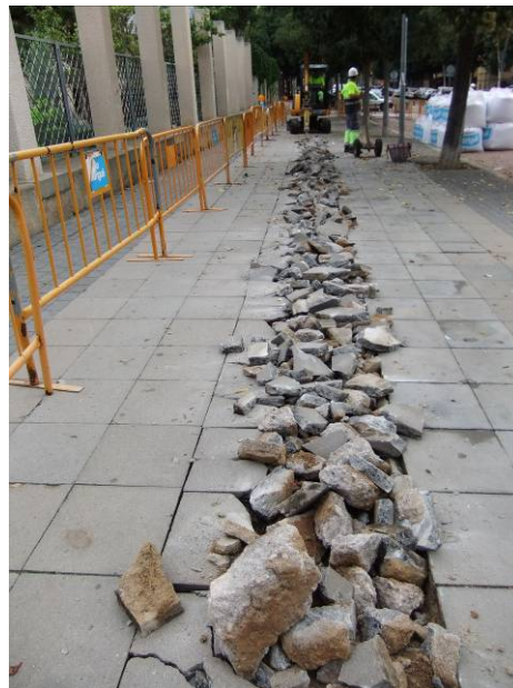
8. Demolició del ferm (UE 001)
