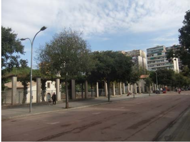
1. Vista de la situació de la rasa.
